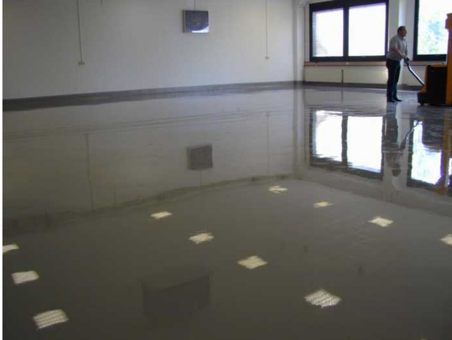
aba Produktionshalle - Aschaffenburg Abteilungsleiter – accent Bausanierung GmbH
