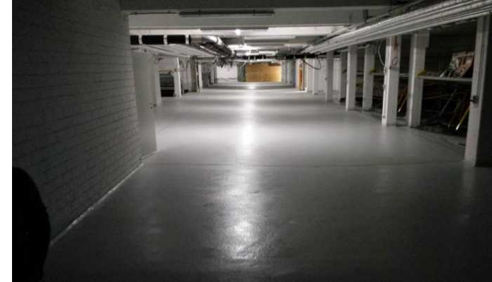
Eurotheum – Frankfurt Gebietsleiter – Bauschutz GmbH
